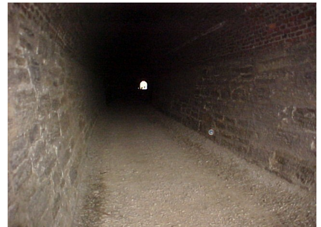
Image visible avec forte variation de l'illumination i : on cherchera à retrouver la composante de réflectivité r à partir du niveau de gris g : g(x) = r(x).i(x)
